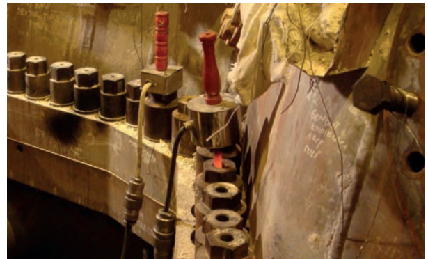
Apriete de perno de rotor (Apriete por Calentadores).
